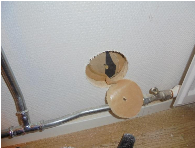
Bild 23. Kontrollhål öppnades i kontor/arbetsrum i vägg mot söder, samma konstruktion som i kök konstaterades.
