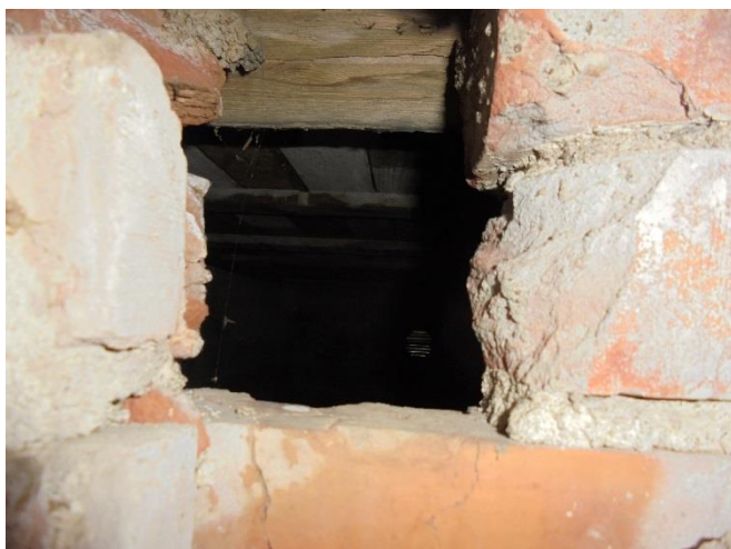
Bild 8. Golvtyp1. Golvbjälklag, kryputrymme under tambur utan tillträde, fotograferat genom glugg i källarvägg.
