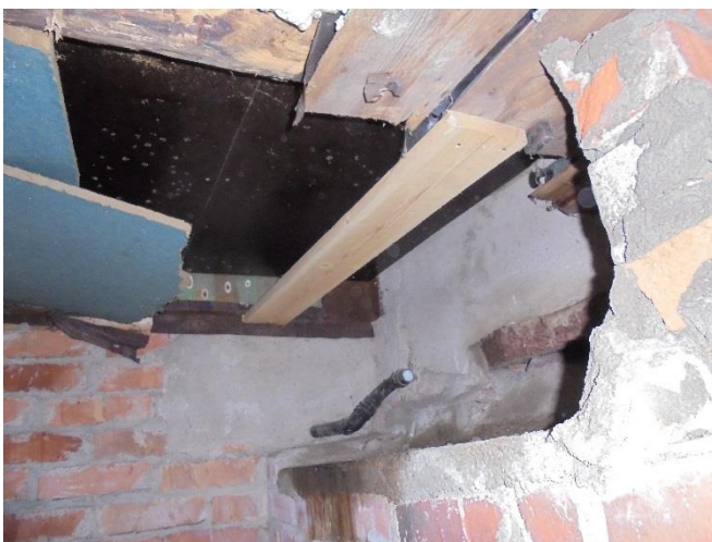
Bild 16. En del av golvet oisolerade del har vattenfast fanerskiva som botten, på skivornas undersida observerades något som kan vara mikropåväxt. Påväxten har högst sannolikt orsakats av att kondensdroppar bildats på skivans glatta undersida och damm eller andra orenheter har gett näring åt påväxten.
