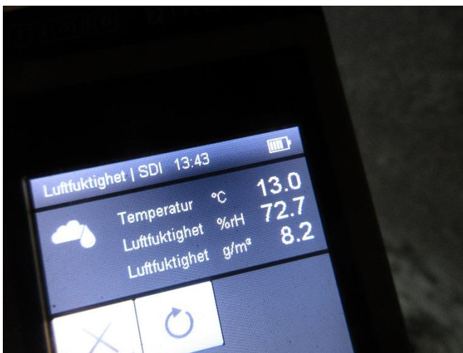
Bild 11. I denna del av krypgrunden är den relativa fuktigheten förhöjd.
