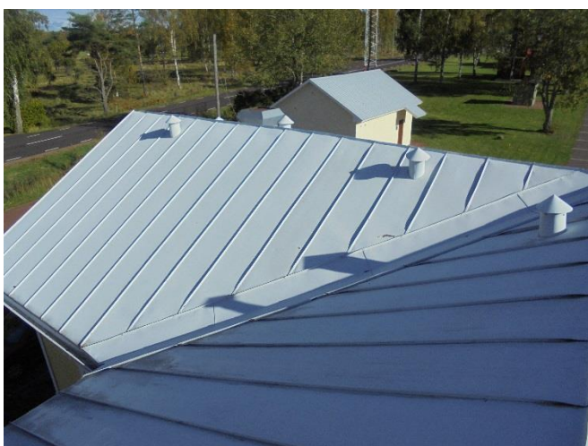
Bild 5. Vattentaket är still största del helt. Några enstaka rostfläckar konstaterades. Tillgång till mellantaket fanns ej.
