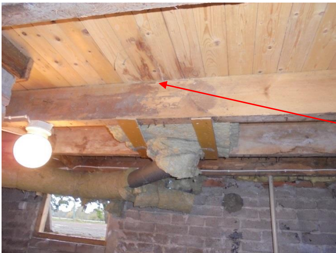
Bild 11. Golvtyp4. Man kunde konstatera att bjälklaget saknar värmeisolering i husets norra del. I kryputrymmet finns ett värmelement.
