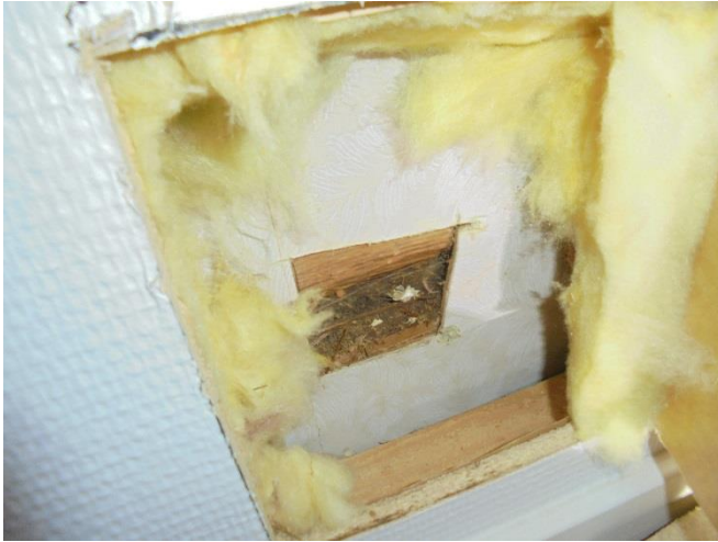
Bild 22. Vägghkonstruktionen öppnades inifrån till stockstommen.
