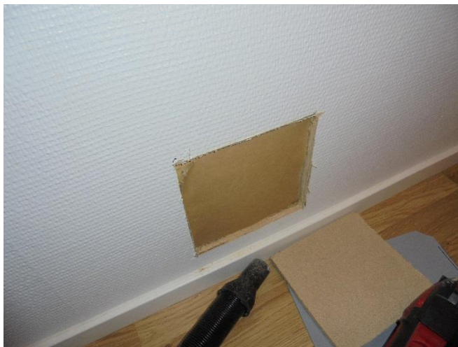
Bild 21. Kontrollhål öppnades i kök/kafferum i yttervägg mot norr. Materialprov (MP1) togs ut vägg av glasullsisolering.
