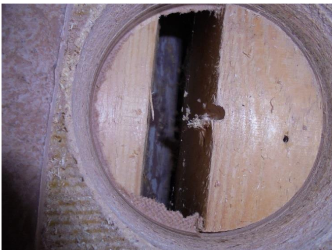
Bild 5. Bärande stock observerades i kontrollhål i golv. Materialprov MP10 togs av regel ovanför. Ingen aktiv mikrobväxt konstaterades.
