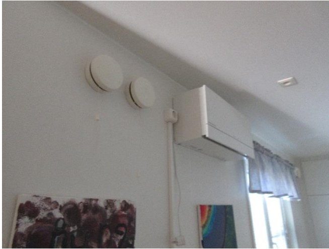
Bild 17. Byggnaden har både en maskinell frånluft samt en maskinell till- och frånluftsmaskin.
