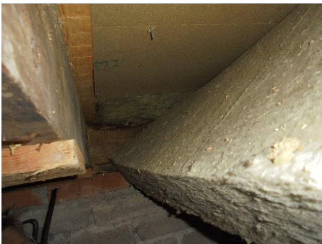
Bild 14. Ställvis observerades isolering, dock är den ej säkert installerad fungerar ej som värmeisolering för golv.
