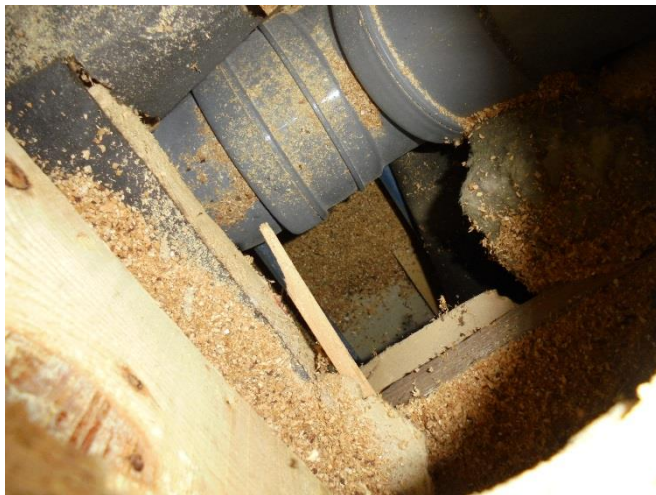
Bild 2. Spånisolering finns i bjälklaget.
