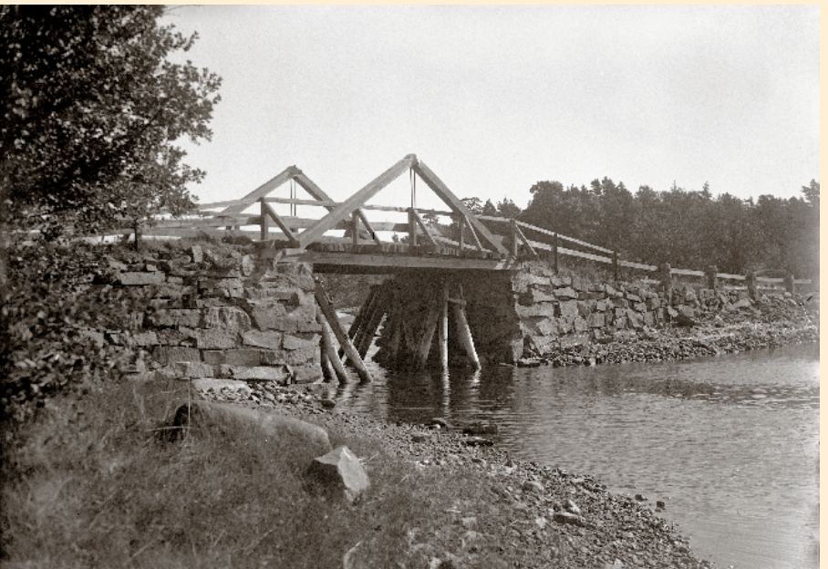
Omkring 1930 rev man den välvda träbron över Lumparsund och ersatte den med ett rakt brolock av trä. Bron fick nu sin karaktäristiska form av de triangulärt ställda balkar, som höll upp brolocket med hjälp av fyra järntenar. Stödstoparna för den tidigare bron lämnades kvar i sjöbottnen.
