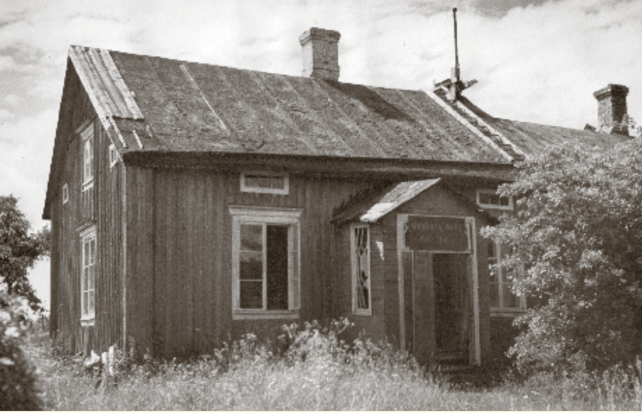
< Den sistas affären på Klubben var Rautas handelsbod, som var inrymd längst söderut i en lång byggnadslänga, som innehöll både ladugård och bostad. Fotografiet är taget i början av 1950-talet, strax innan byggnaden revs.
