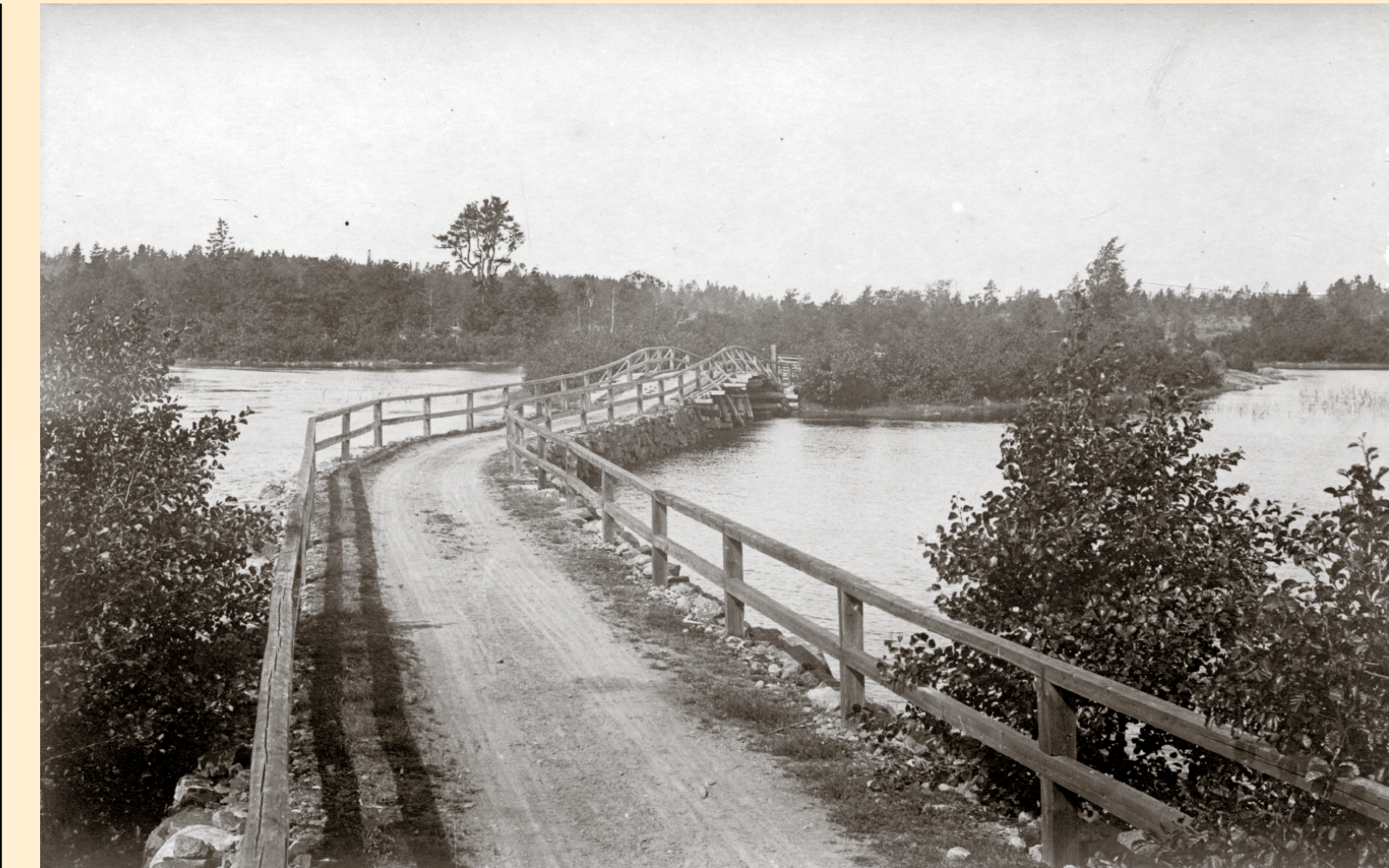
Fotografiet av den första bron över Lumparsund är taget från Lumparlandssidan – strax norr om dagens informationsskylt – ungefär år 1900. Den lätt välvda bron var konstruerad av naturligt böjda stockar av furu. Bakom bron skimtar den stora, stadiga grind som placerades på Kummelören för att markera gränsen till Lemland.
