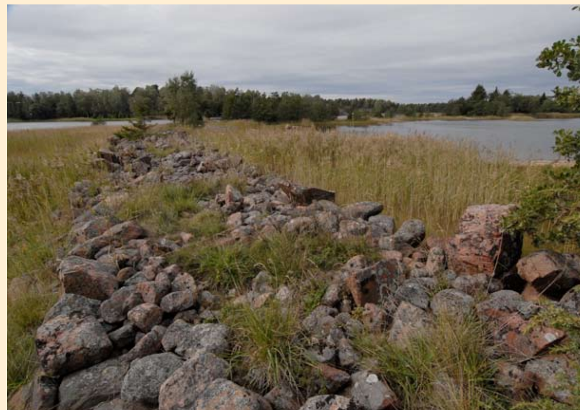
Den gamla vägbanken vid färjfastet i Skag, Lumparland, är en imponerande anläggning. Hit släpade bönder från hela Lumparland sten och sand åren 1844-1846. Vid högvatten och storm sköljdes vägflyllningen bort så underhållet krävde varje år 100 dagsverken. När bron över sundet och anslutande vägar byggdes togs mycket material till dem från den gamla vägbanken.
