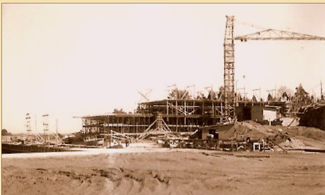
Siljaterminal under byggnation
