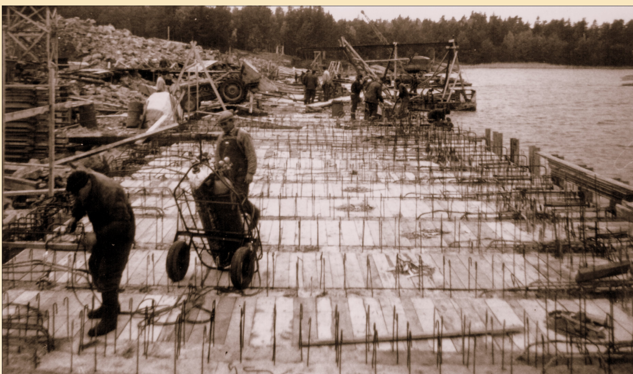
Långnäs hamn under byggnation
