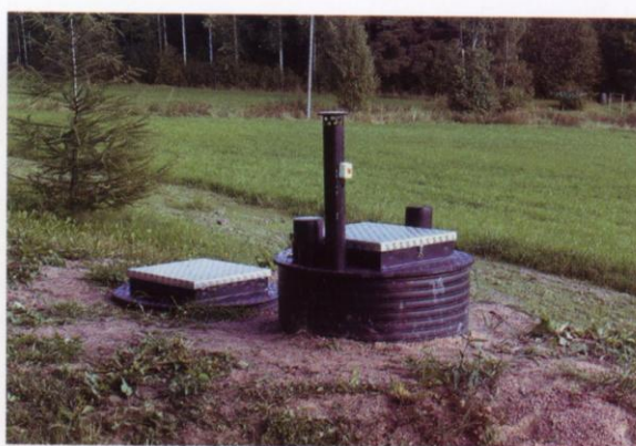
Bild över ett minireningsverk på plats i terrängen
